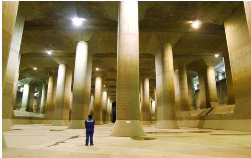
<그림 IV-11> 일본 도쿄의 지하 빗물 방수 터널 (수압조)
