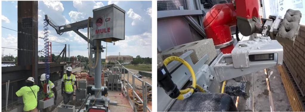
〈그림 12〉 컨스트럭션 로보틱스의 MULE135(좌)와 SAM100(우) 사례
