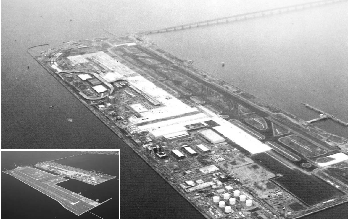
간사이 신공항의 건설 현장(대)과 완공 뒤 전경(소).
