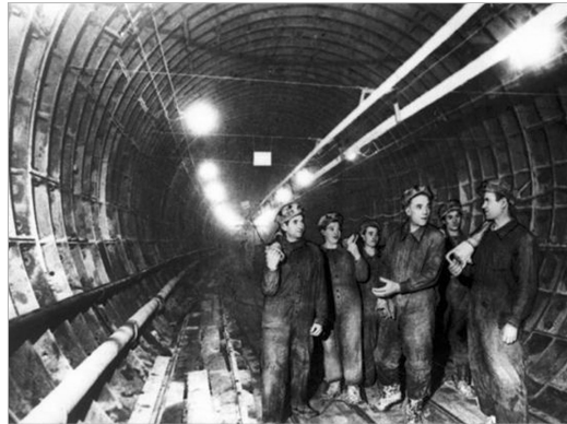
모스크바 지하철 1호선 지하 선로 건설공사.
