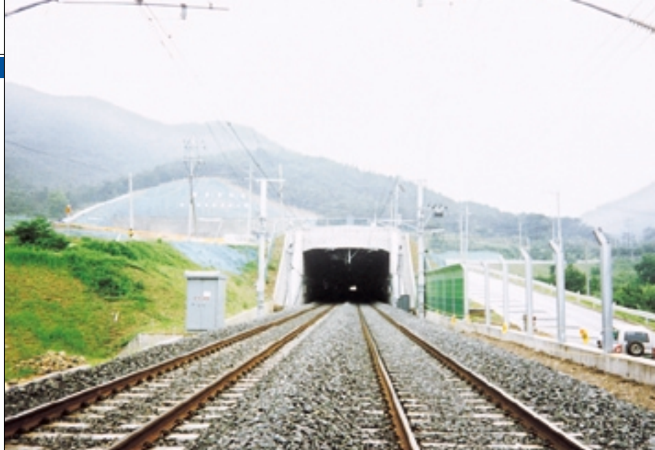
신설 무월터널 개작 박스 전경.
