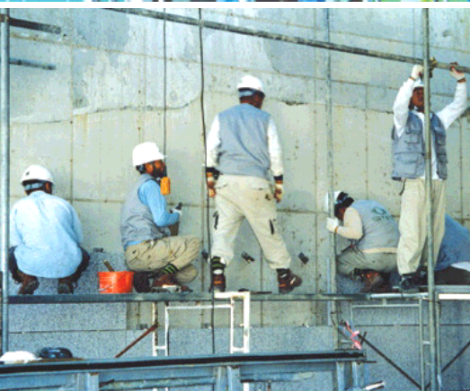
커튼월 공사(상)와 석공사(하) 장면.
