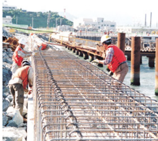
잔교보 건설을 위한 철근 배근 작업.
