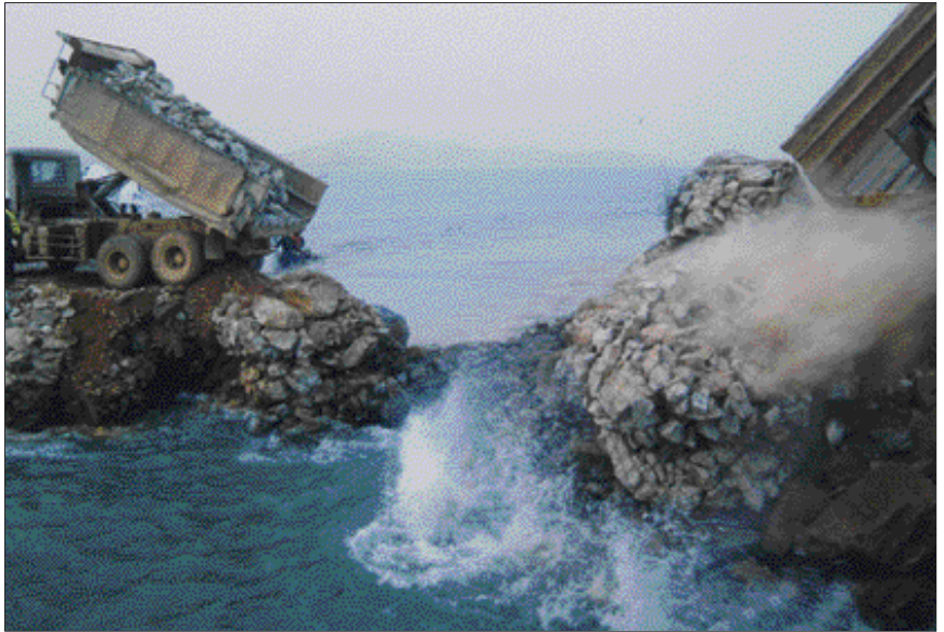
최종제철구간의 끝막이 공사.
