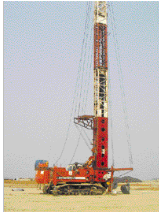
플라스틱관을 타입하여 지중의 간극수를 배출시키는 PBD 작업.
