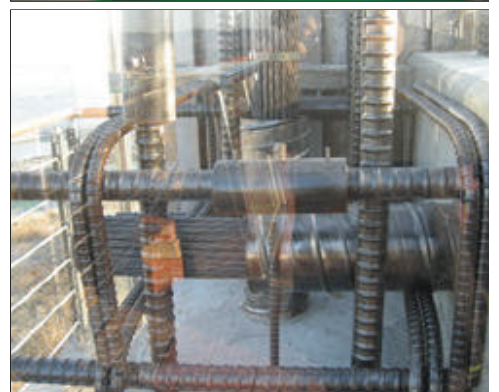
(상) 국내 최초로 일체형 상부 구조물 장치가 가능토록 설계된 1호기 원자로 설치 작업, (하) 원자로 건물에 쓰이는 철근 샘플.
