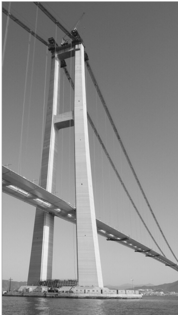
시공 중인 주탑.
