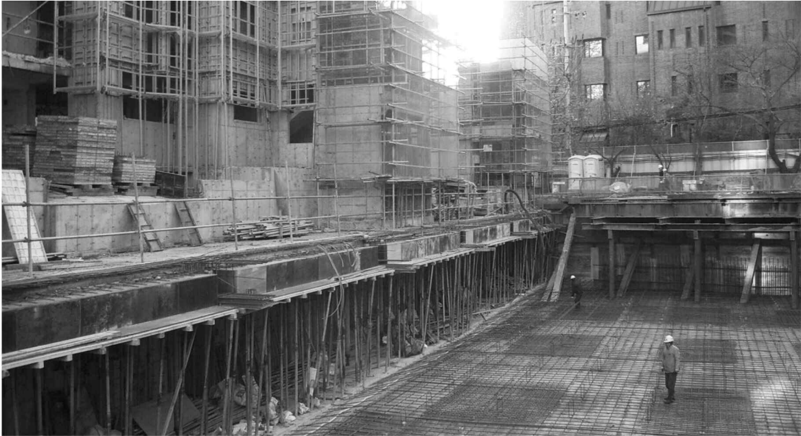
리모델링 공동주택의 지하 주차장 기초 공사.
