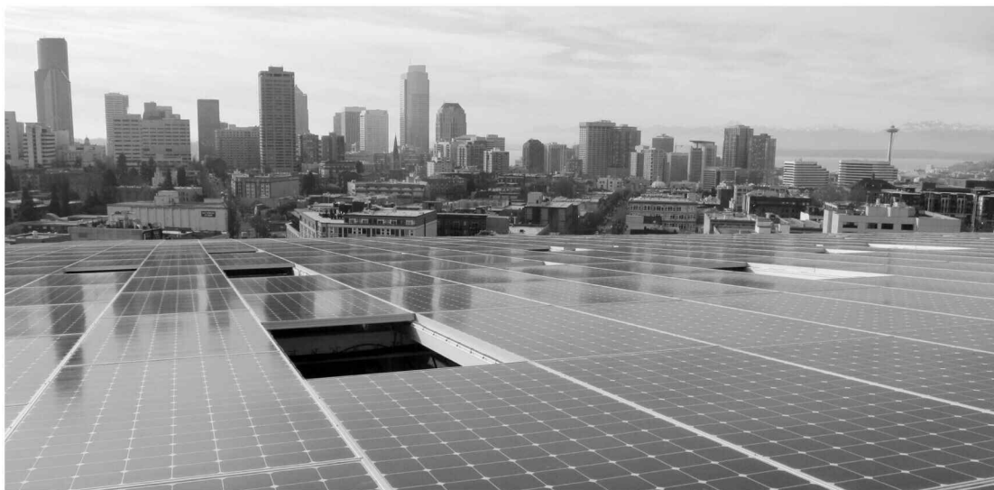
태양광 패널로 덮인 불리트센터의 옥상 전경.
