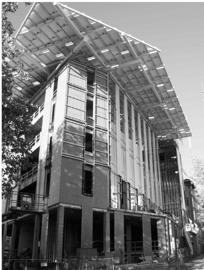
공사 마무리가 한창인 불리트센터.
