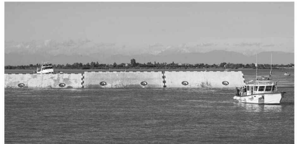
이동식 수문 테스트 장면.
