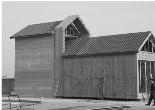
〈그림 1〉 3D Printed House(중국 상하이)
