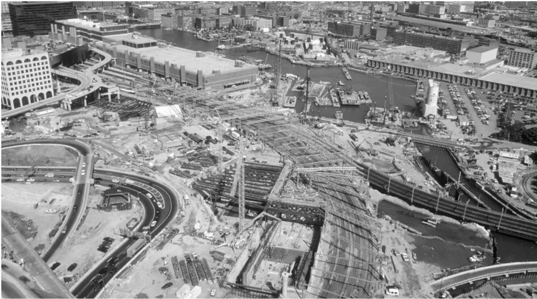
Big Dig 공사 전경.
