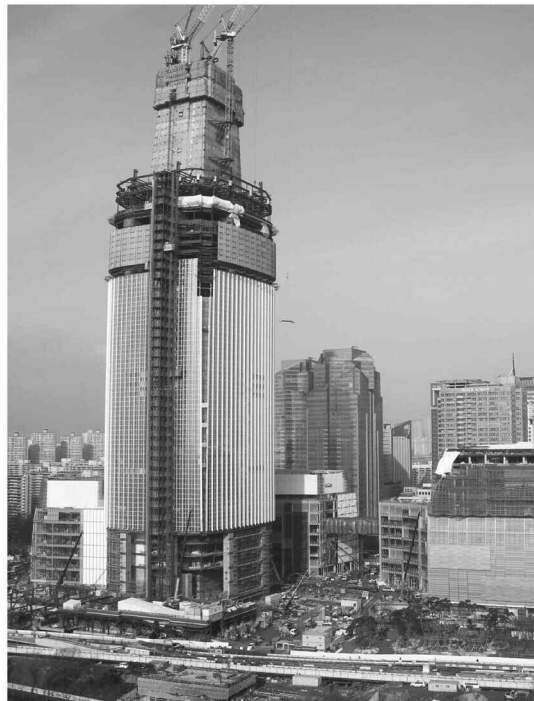
시공 중인 월드타워.
