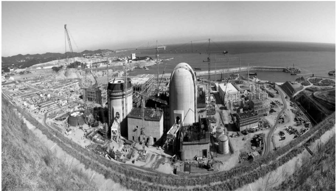
올해 공공시장 부활은 플랜트 분야에서 시작되고 있다. 특히, 신고리 원전 5·6호기는 올해 공공시장 최대어로 부각되고 있다. 사진은 신고리 원전 1·2호기 건설 장면.
