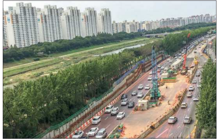
서부간선지하도로 민간투자사업 건설공사 현장(출처: 서울시 건설알림이).
