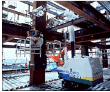
c) 철골구조 용접 로봇
