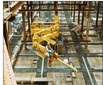
b) 평면 콘크리트 타설 로봇
