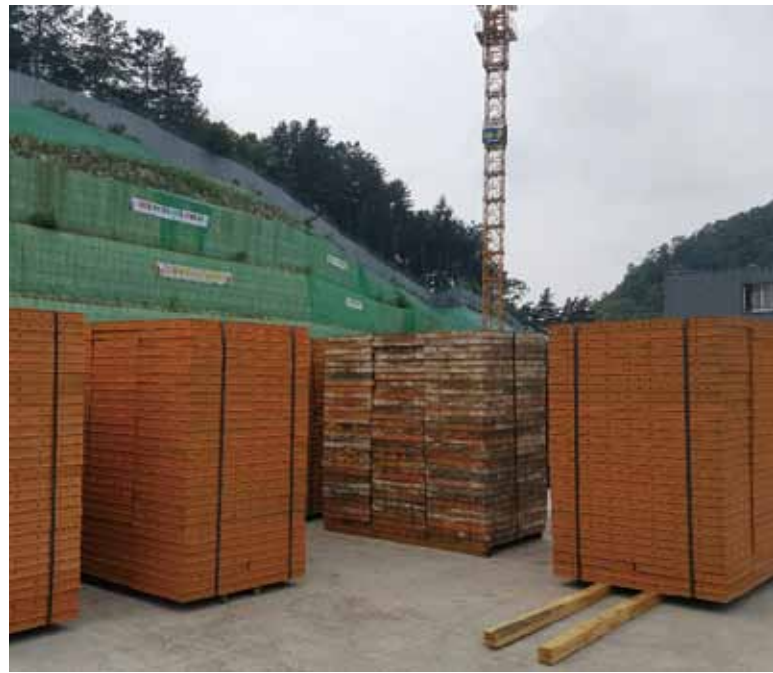
정부는 건설산업의 발전을 저해하는 규제를 없애는 등 건설산업의 생태계를 혁신하는 노력을 해야 한다. 사진은 발주자가 직접 구매해 제공한 학교 공사의 건설 자재.
