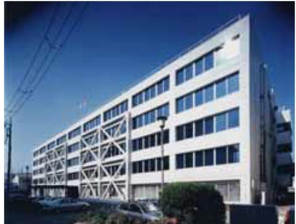
〈사진 2〉 외부 부착 프레임 증설 사례 9)
