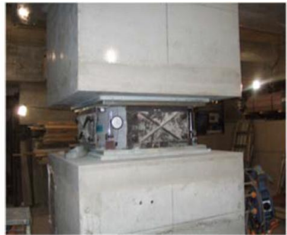
〈사진 6〉 면진 장치 설치 사례 13)
