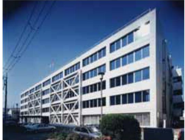
〈사진 2〉 외부 부착 프레임 증설 사례 9)
