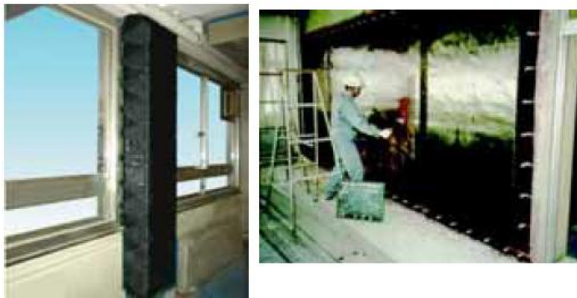
〈사진 4〉 탄소섬유 시트에 의한 내진 보강 사례(좌 : 기둥, 우 : 벽) 10)
