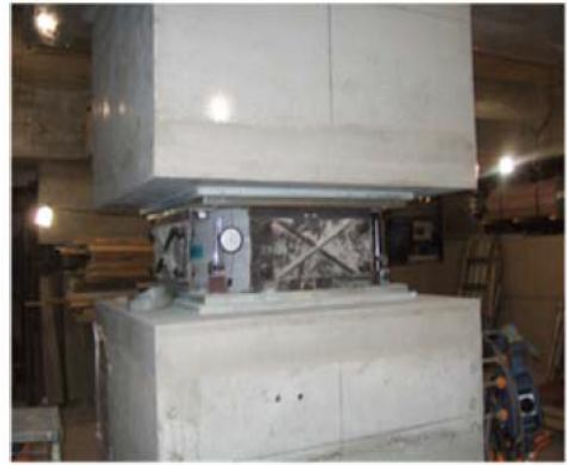
〈사진 6〉 면진 장치 설치 사례 13)
