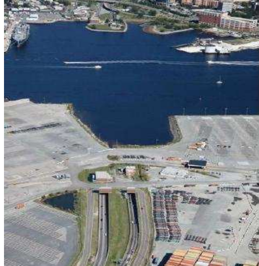
<그림 IV-10> ③포츠머스(Portsmouth)시 측으로부터의 터널 진입 구간
