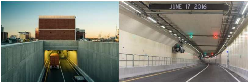
<그림 IV-11> ①새로운 미드타운터널(New Midtown Tunnel) 내부
