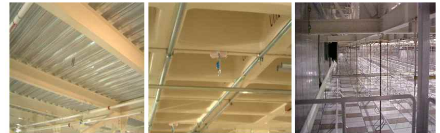
추락 방지 안전고리 거치대 설치 1 추락 방지 안전고리 거치대 설치 2 걸을 수 있는 작업공간 확보 자료 : 최상준(2012), 국의 건설업 안전보건 동향, 건설업의 안전과 보건, 2012년 추계 한국산업위생학회 참조.
