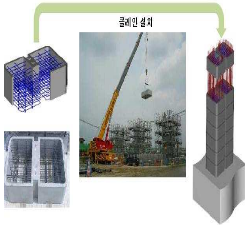
<그림 3> 거푸집 Precast 시공 사례(三井住友建設)
