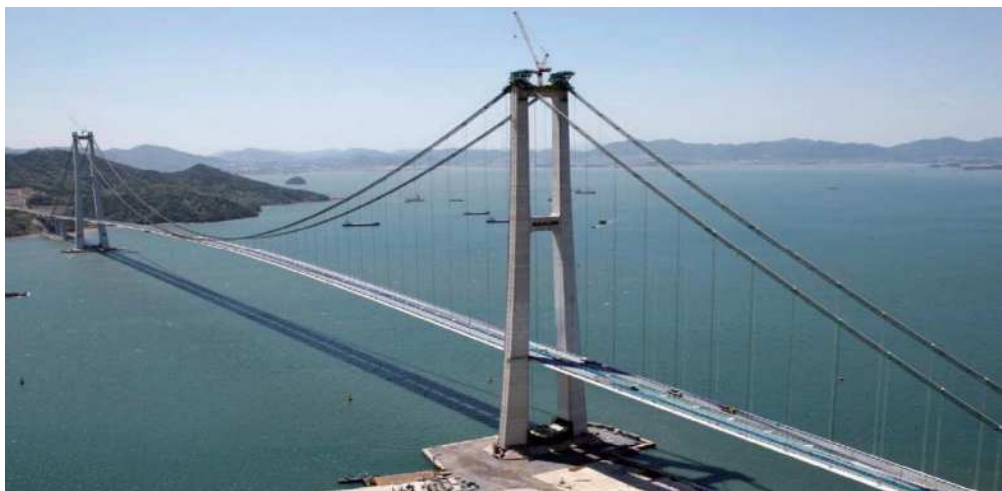
<그림 31> 이순신대교 건설 중 전경
