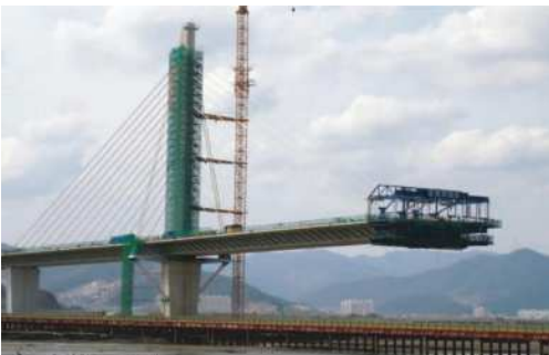
(b) F/T(Form Traveler)를 사용한 거더 시공
