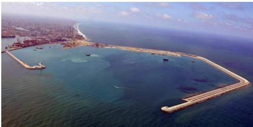
<그림 47> 스리랑카 Colombo Port Expansion Project
