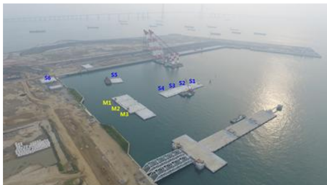
<그림 49> 인천항 국제여객부두 부잔교 시공 현황
