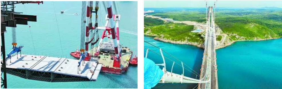
(a) 현수교 구역에 강상판을 설치
