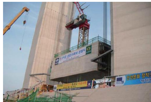
(b) 상단 가로보의 Heavy Lifting
