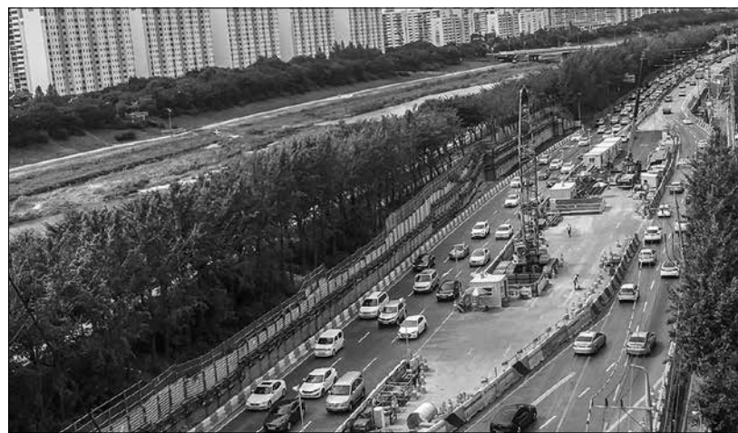
서부간선지하도로 민간투자사업 건설공사 현장(출처 : 서울시 건설알림이).
