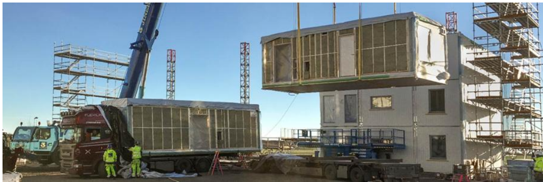
〈그림 19〉 BoKlok의 주택 조립 현장
