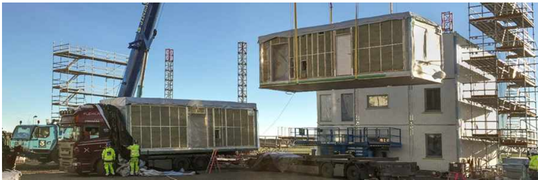
〈그림 19〉 BoKlok의 주택 조립 현장
